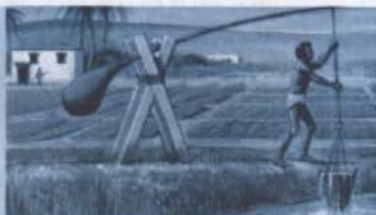
Người Ai Cập dùng cần vọt để đưa nước lên ruộng
